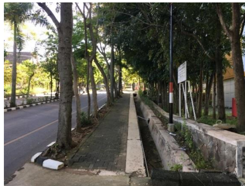
Gambar 5. Jalur pejalan kaki pada koridor jalan utama kampus ruas selatan
